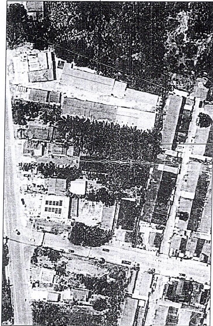
พื้นที่ว่างเพื่อระบายน้ำ ยาว 120 เมตร รือถอนต้นไม้ ขุดลอกคูระบายน้ำ
